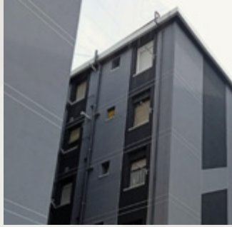
Parque Vosa , 21 Móstoles Aislamiento térmico SATE
