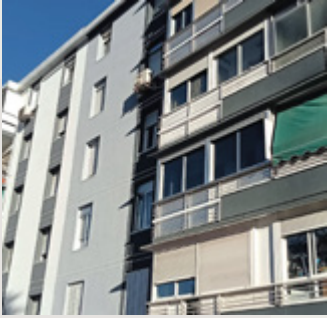
Parque Vosa, 19 Madrid Imprimación asfáltica
