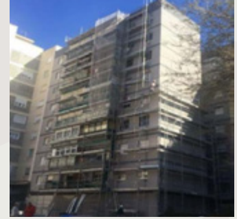
Benito Pérez Galdós, 5 Móstoles Aislamiento térmico SATE
