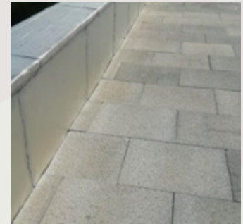
José de Cadalso, 54 Madrid Imprimación asfáltica
