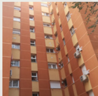
Bolarque, 3 Madrid Imprimación asfáltica
