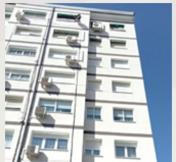
Desarrollo, 4 Madrid Imprimación asfáltica
