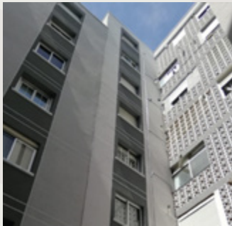
Alcalde de Zalamea, 4 Madrid Aislamiento térmico SATE, Aislamiento de cubierta Estanqueidad al aire
