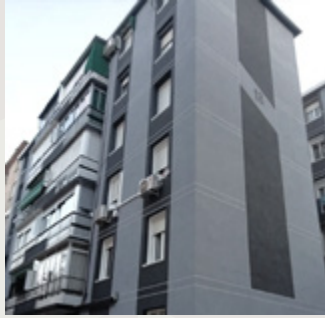
Parque Vosa, 18 Madrid Imprimación asfáltica
